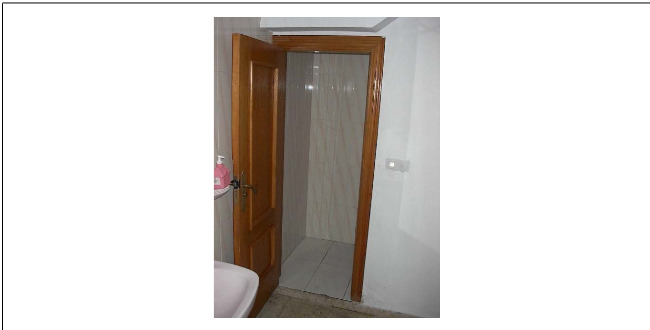
FOTO 12 | ASEO CAMERINO 2- EL INODORO ESTÁ DEBAJO DE UNA ESCALERA- HABRÍA ESPACIO PARA ADAPTAR ESTE ASEO
