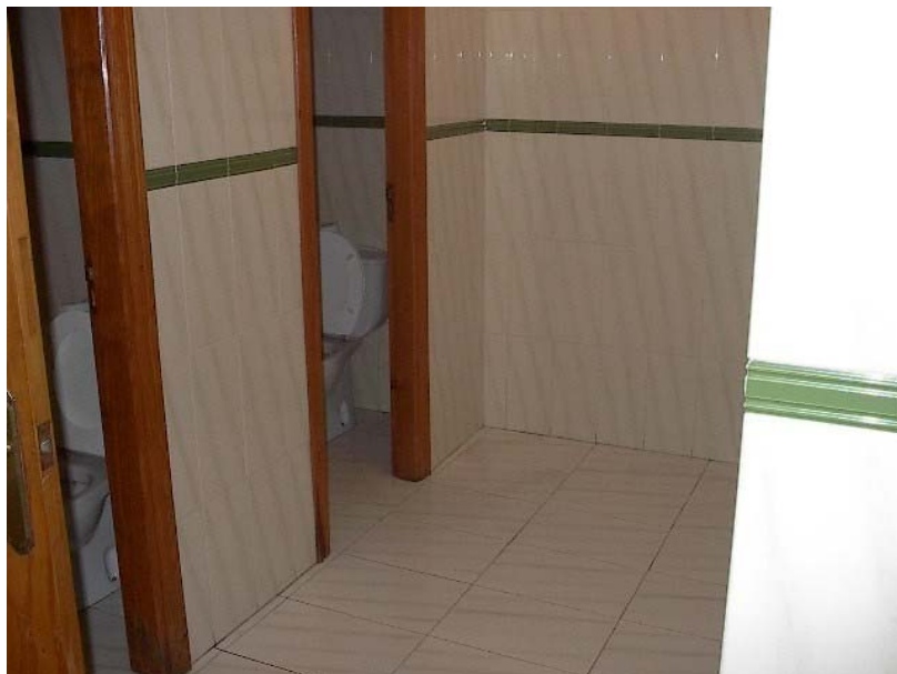
FOTO 7 | ASEOS MASCULINOS DE PLANTA BAJA- CABINAS
