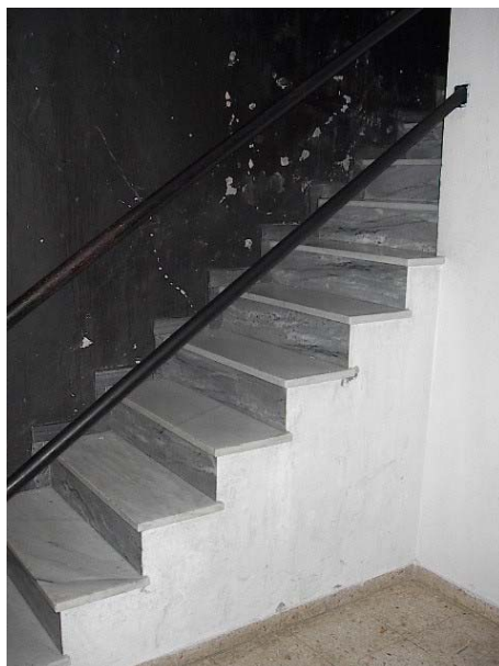
FOTO 9 | ESCALERAS DE ACCESO A LOS CAMERINOS DESDE EL ESCENARIO
