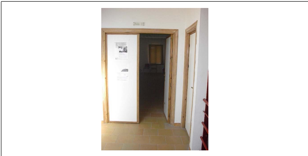
FOTO 22 | ENTRADA A LA SALA DE USOS MÚLTIPLES
