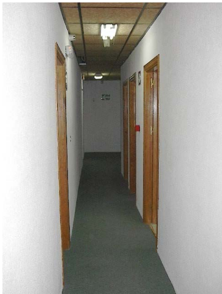
FOTO 18 | PASILLO DE LAS CABINAS DE CONTROL
