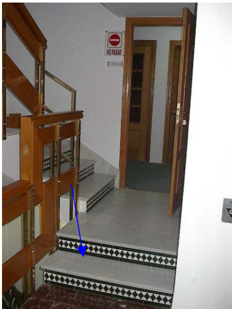
FOTO 17 | ENTRADA A CABINAS DE CONTROL DE LUCES Y SONIDOS DEL SALÓN DE ACTOS- ESCALONES AISLADOS
