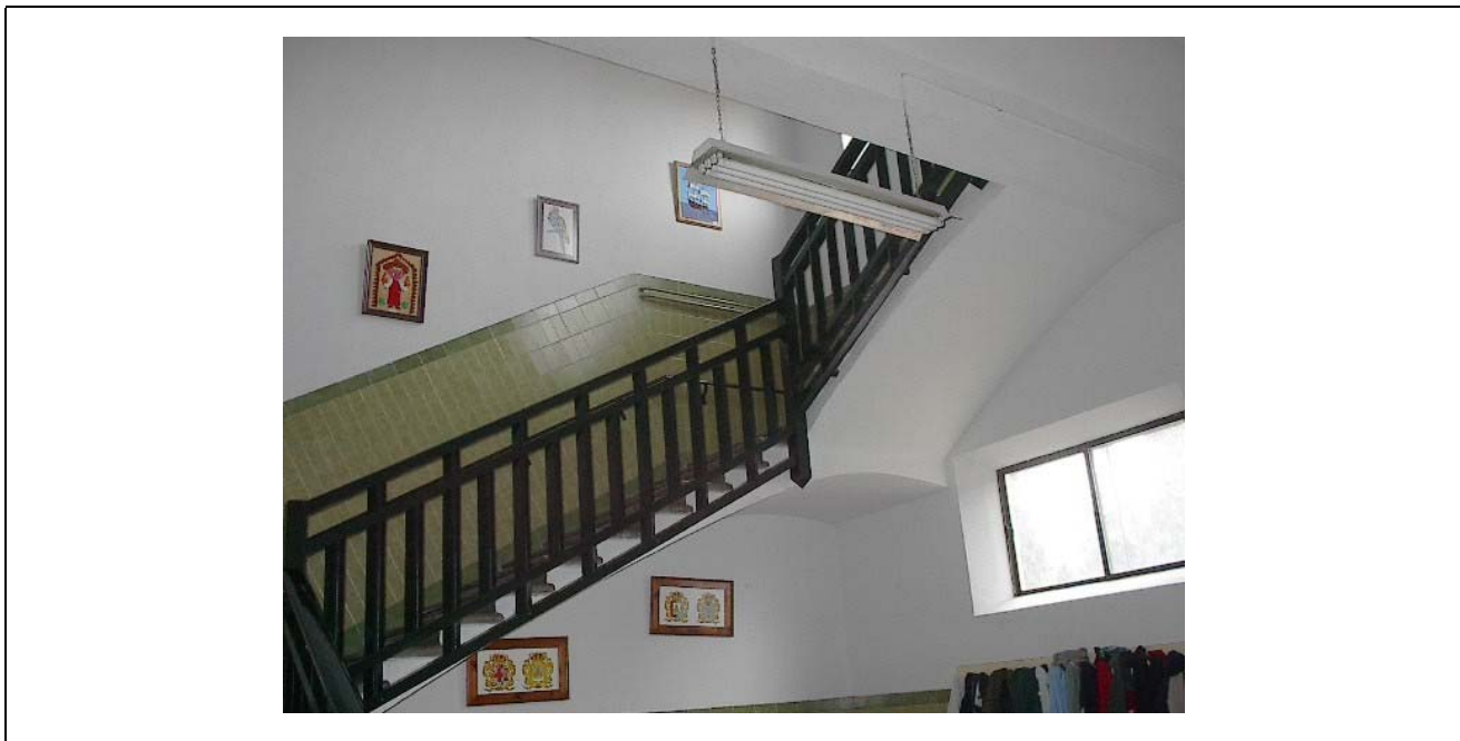
FOTO 5 | HUECO DE LA ESCALERA- POSIBLE LUGAR PARA COLOCAR EL ASCENSOR
