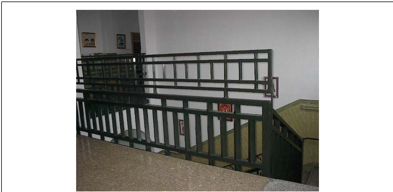
FOTO 6 | DESMBARCO DE LA ESCALERA EN LA PLANTA ALTA
