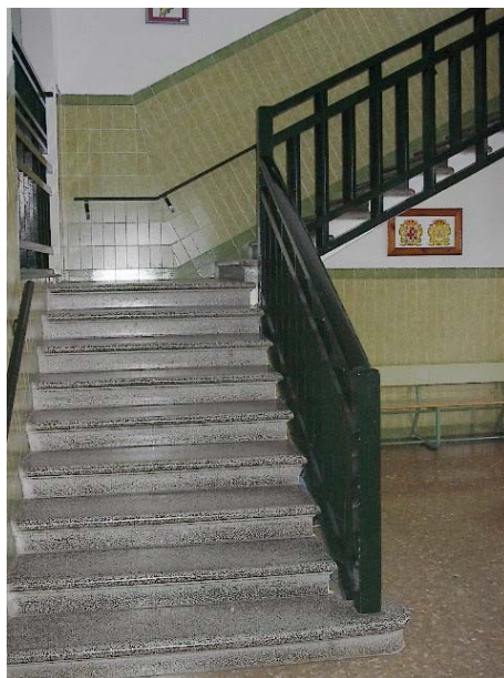
FOTO 4 | ARRANQUE DE LA ESCALERA
